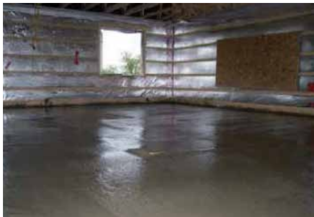
Thermason VB après la coulée de béton Thermason VB after concrete pour
